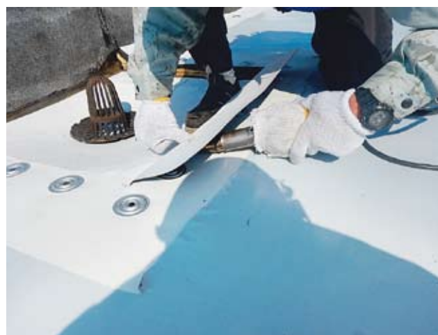
④ドレン廻り処理
