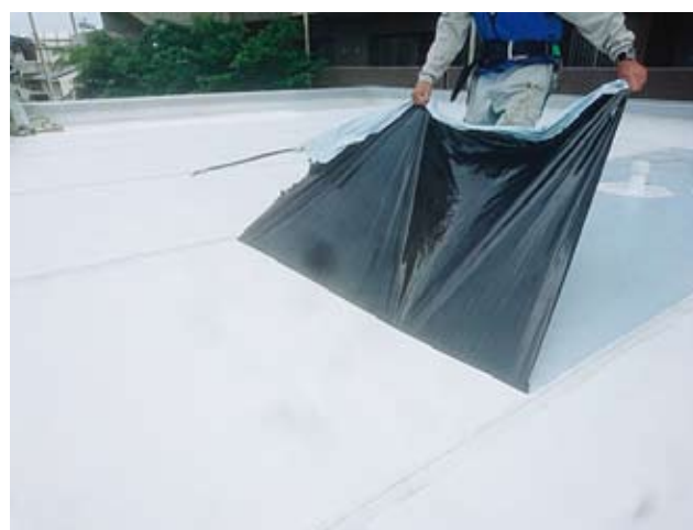
⑥APEELフィルムを剥がす(完成)
