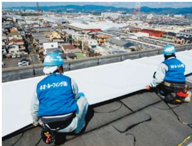
①フリースバックTPOシートの敷布
