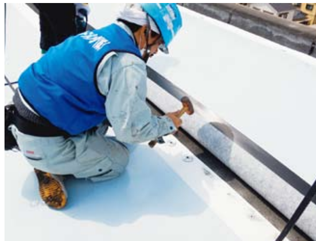
②接合部内にビス・ディスクの打設
