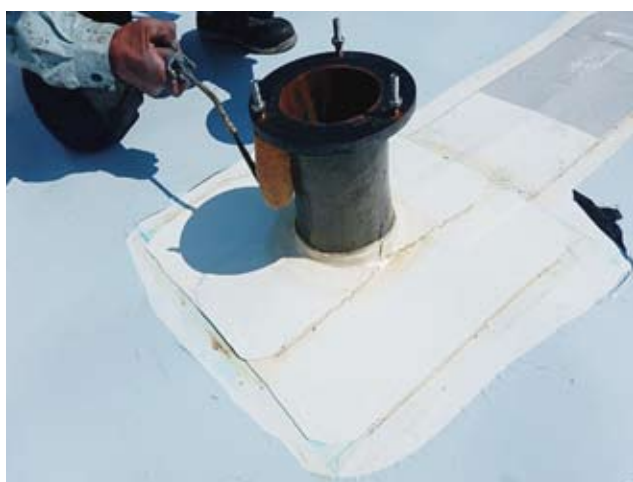
⑤立上り・役物廻りのTPOシート貼り付け
